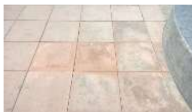
Рисунок 2 – Вторичные высолы на поверхности мощения.
